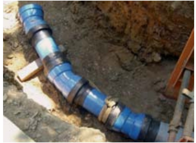
Bild 4: Richtungsänderung im offenen Rohrgraben
