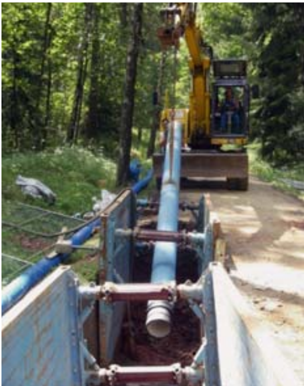
Bild 6: Absenken eines Rohres in die Montagegrube
