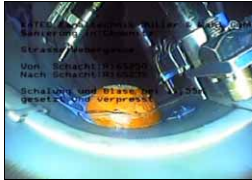
Schalung für Hausanschluss
