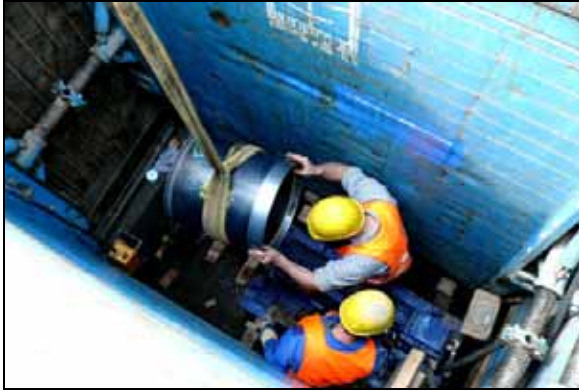
Ablassen der Kurzrohrmodule in die Baugrube
