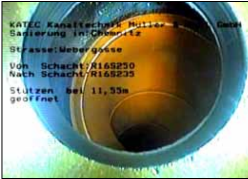
Aufgefräste Hausanschlussbohrung
