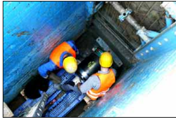
Einschub eines Kurzrohrmoduls (Berstmaschine, Neurohr und Arretierung)
