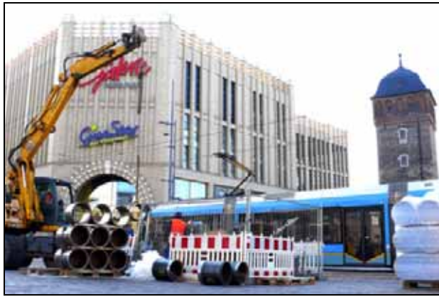
Der Verkehrsbetrieb konnte während der Baumaßnahme aufrechterhalten werden. (Blick auf den „Roten Turm“ Chemnitz)
