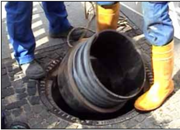
Die Bergung der Bersthülse erfolgt ohne Abnehmen des Schachtkonus.
