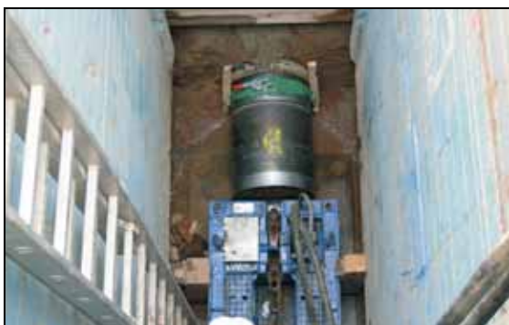
Neurohr mit Berstmaschine
