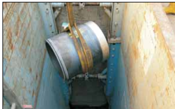
Ablassen der Neurohrmodule
