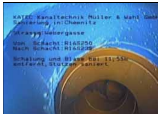
Fertiger Hausanschluss
