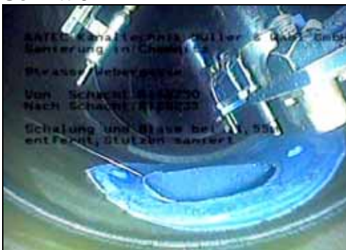
Verspachtelung der Hausanschlüsse mit 2-Komponenten-Epoxidharzleim
