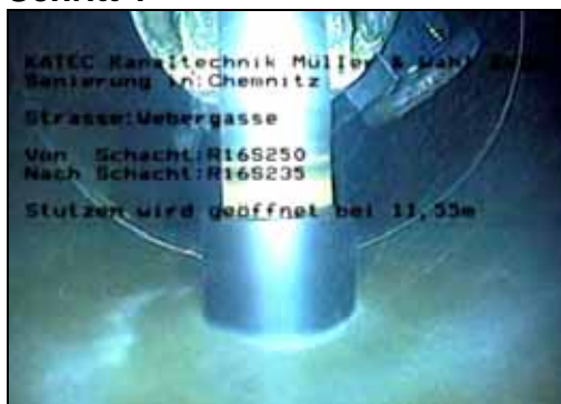
Aufbohren mit diamantbesetztem Kernlochbohrer
