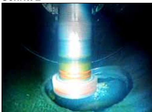
Auffräsen der Kernbohrung auf das erforderliche Maß
