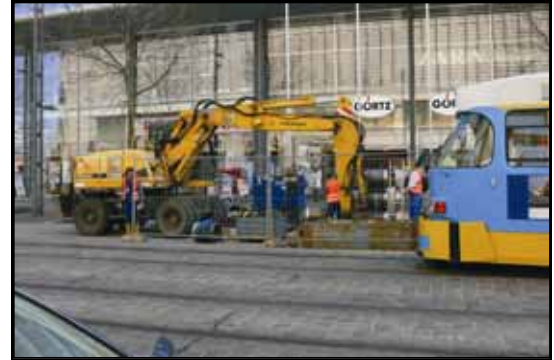
Die Baustelle in der Chemnitzer Innenstadt nahe der Zentralhaltestelle Straße der Nationen – der Straßenbahnbetrieb konnte während der gesamten Bauzeit aufrechterhalten werden.
