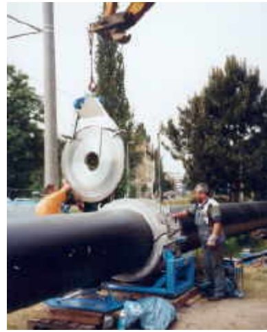
Die Rohre werden mittels Heizelementstumpfschweißen verschweißt.
