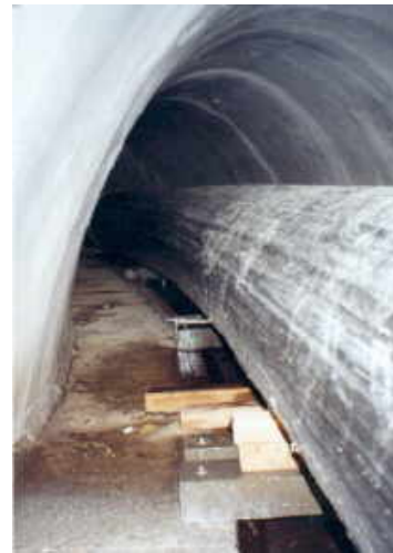
Der Rohrstrang wird in den Kanal eingezogen.
