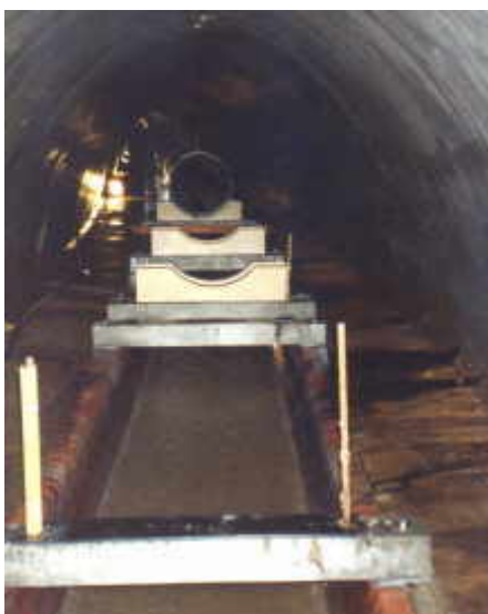
Das Rohr wird auf den Auflagern befestigt.
