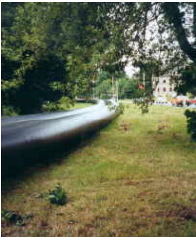
Die verschweißten Rohrstränge liegen zum Einzug bereit.
