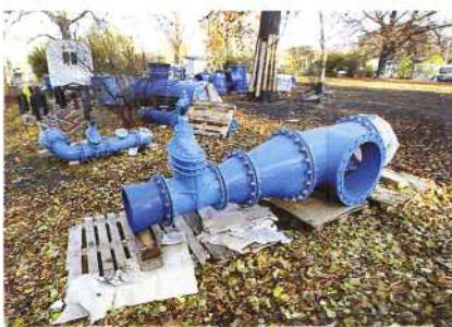
Vorgeschweißte Rohrstränge und vormontierte Knotenpunkte am Kronstädter Platz.
