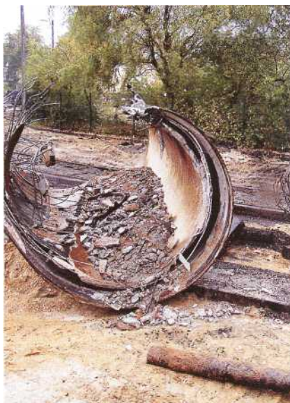
Ein demontiertes Teilstück der alten Stahlbetonleitung aus der Startgrube.
