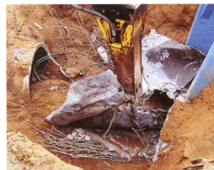
Die alte Stahlbetonleitung wird getrennt.
