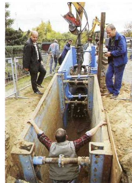
200 Meter lang war der Rohrstrang vom Kronstädter Platz zum Laubegaster Ufer.
