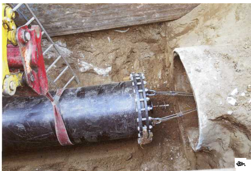
Aufnahme vom Beginn des Rohreinzuges in der Startgrube des Kronstädter Platzes. In die vorhandene Stahlbetonleitung wurde eine 800er PE-HD-Leitung eingezogen.
