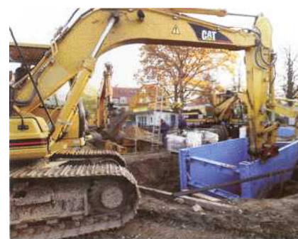
Blick auf die Startgrube Kronstädter Platz.
